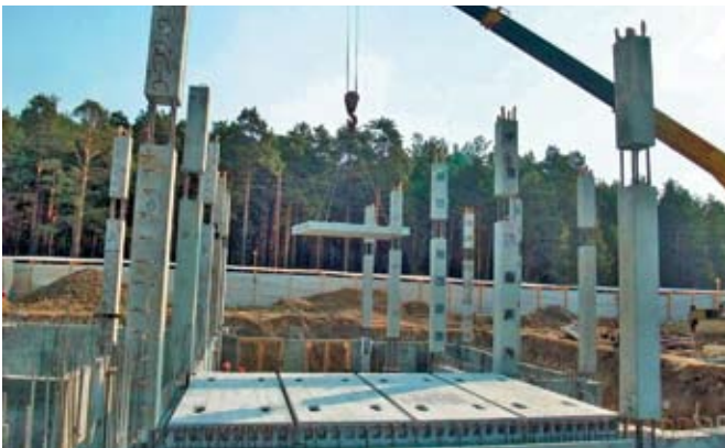
Рис. 4. Монтаж сборных железобетонных конструкций с использованием автокрана
