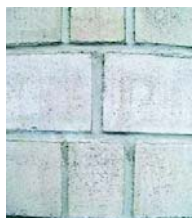
Фото 3. Стена из известняка была обработана гидрофобизатором (камень сохранил свой первоначальный вид)
